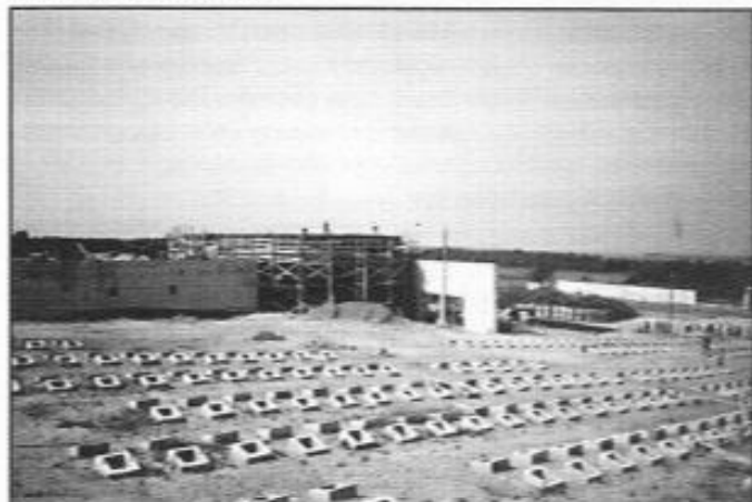
Obiekt ceremonialny z kaplicami pogrzebowymi, krematorium i chłodniami.
