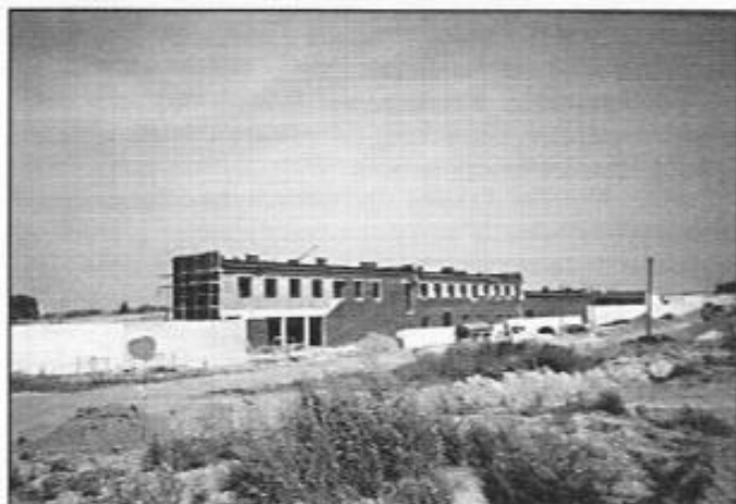
Budynek administracyjno - handlowy.
